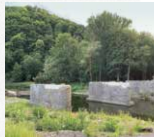
Zerstörte Brücke bei Dernau – ein Jahr nach der Katastrophe noch nicht wiederhergestellt
