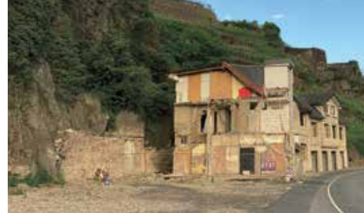
Offene Seite eines Hauses, welches zur Hälfte weggerissen wurde, bei Dernau
